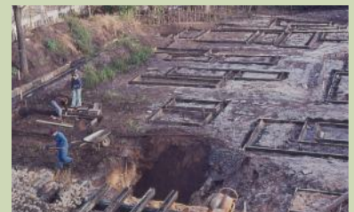
Systemanlage im Bau
