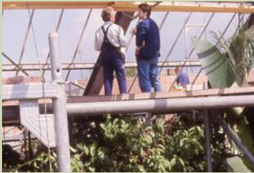
Das neue Dach der Schaugewächshäuser
