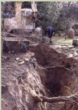
Aufgrabungen für Leitungsverlegung
