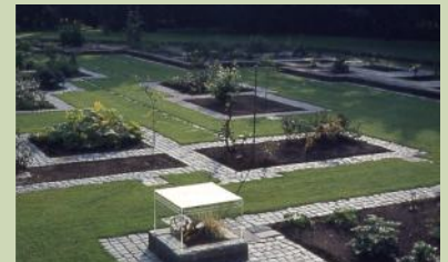
Systemanlage kurz nach der Fertigstellung
