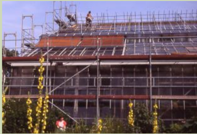
Neuverglasung der Schaugewächshäuser
