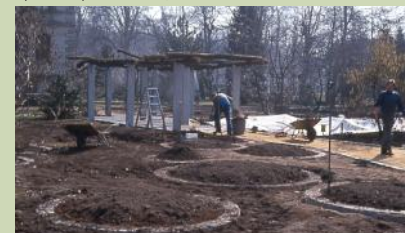
Ökol.-Morph. Anlage im Bau
